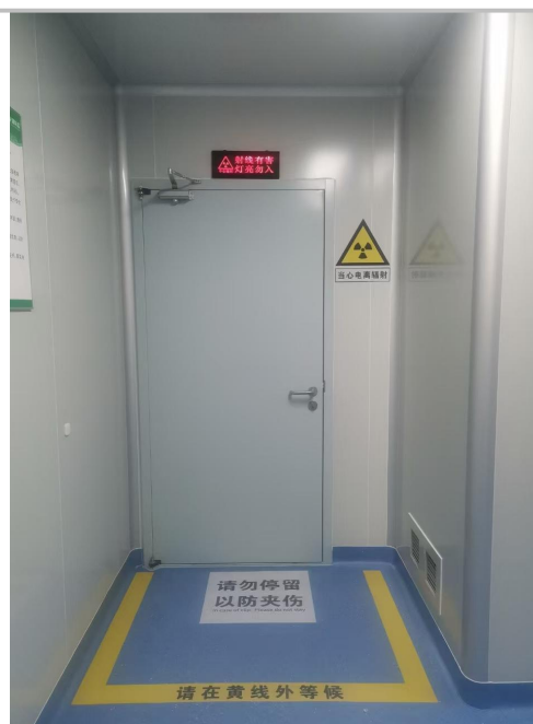
DSA 机房控制室防护门、电离辐射标志、门灯联动装置、警示线、警示语等
